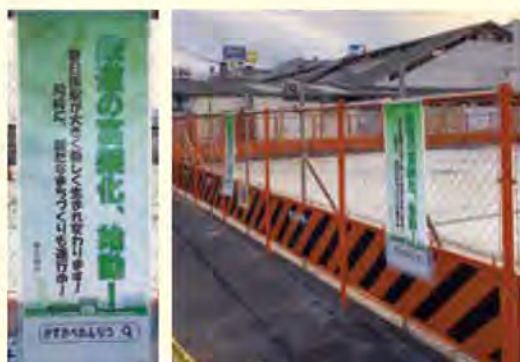
▲解体撤去工事が完了した春日部駅東口改札前テナントビル
